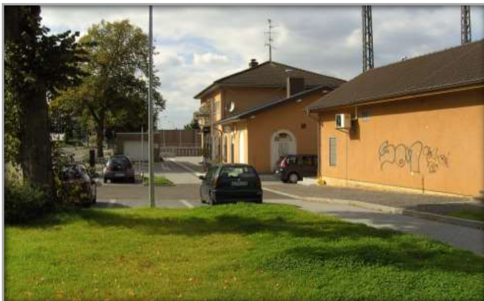
Park&Ride-Anlage am Bahnhof Langerwehe
