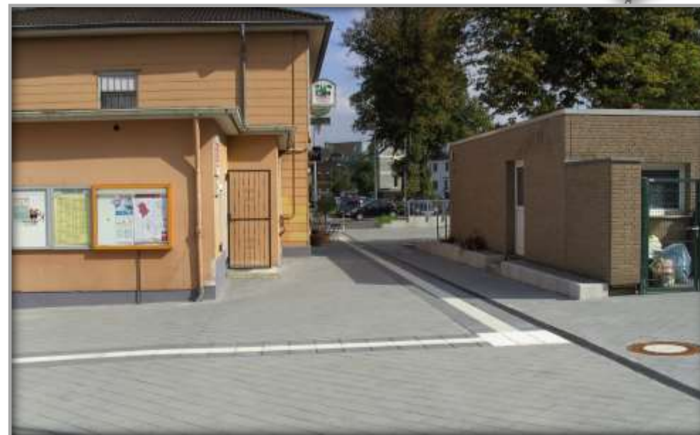
Empfangsgebäude mit neu gestaltetem Vorplatz
